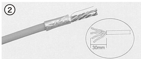
LANケーブルの外皮を30mm程度むき、より線ごとにケーブルを広げます。
