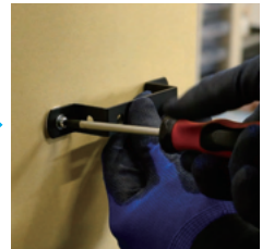
ネジを締めて固定
