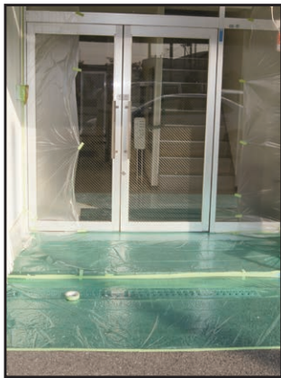
玄関周りの床面養生に
