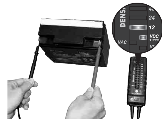
DC(+/-)電圧の測定
