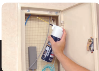
電話線の通線作業にも
